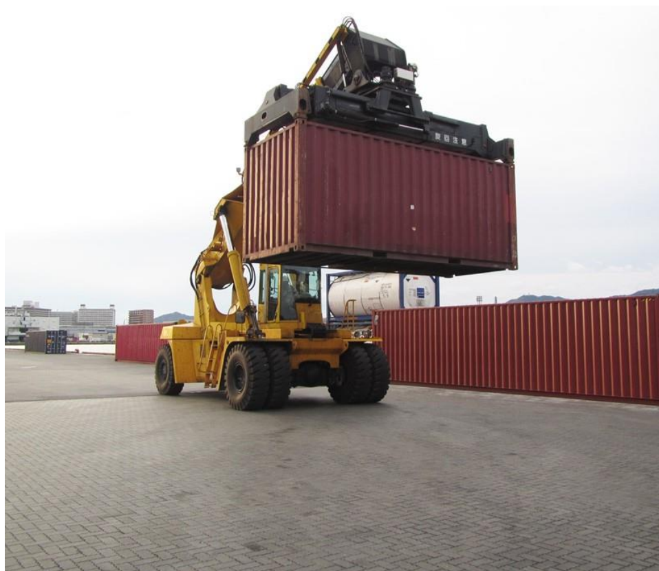
神戸港コンテナターミナルのインターロッキングブロック舗装(その2)
