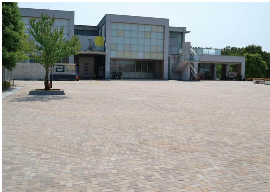
写真1 広場に使用されたインターロッキングブロック舗装
