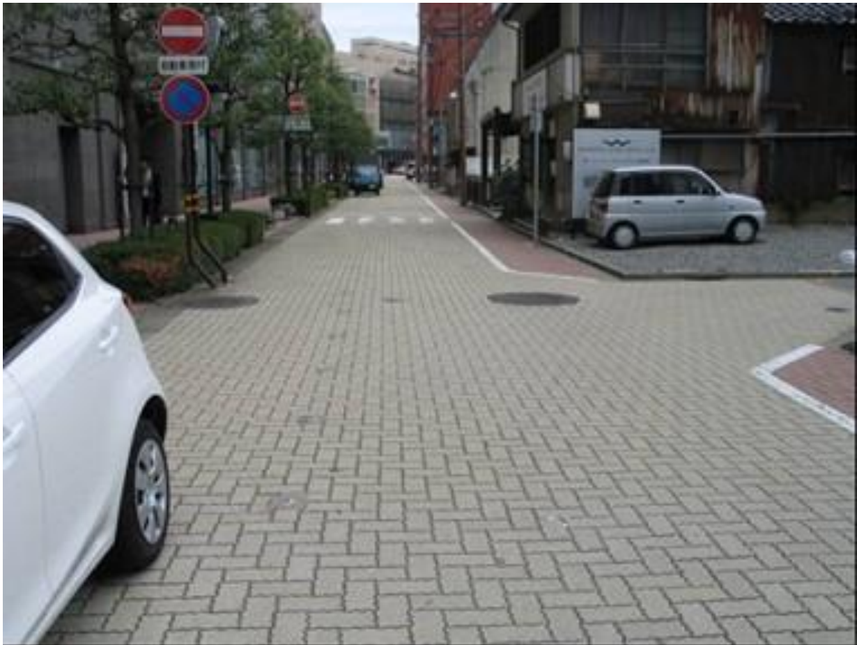
写真2 波形型 IL ブロックの施工例
