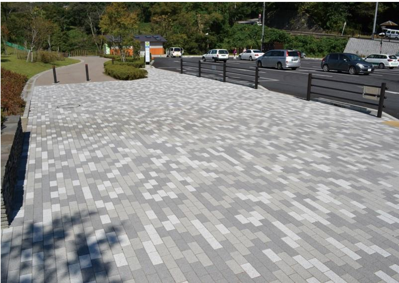
写真1 ストレート型 IL ブロックの施工例
