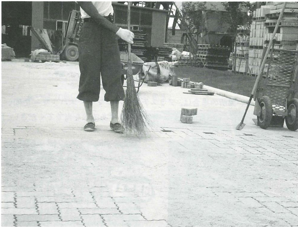
▲ブロック上へ均一に散布した砂を、目地内に掃き込みます。
