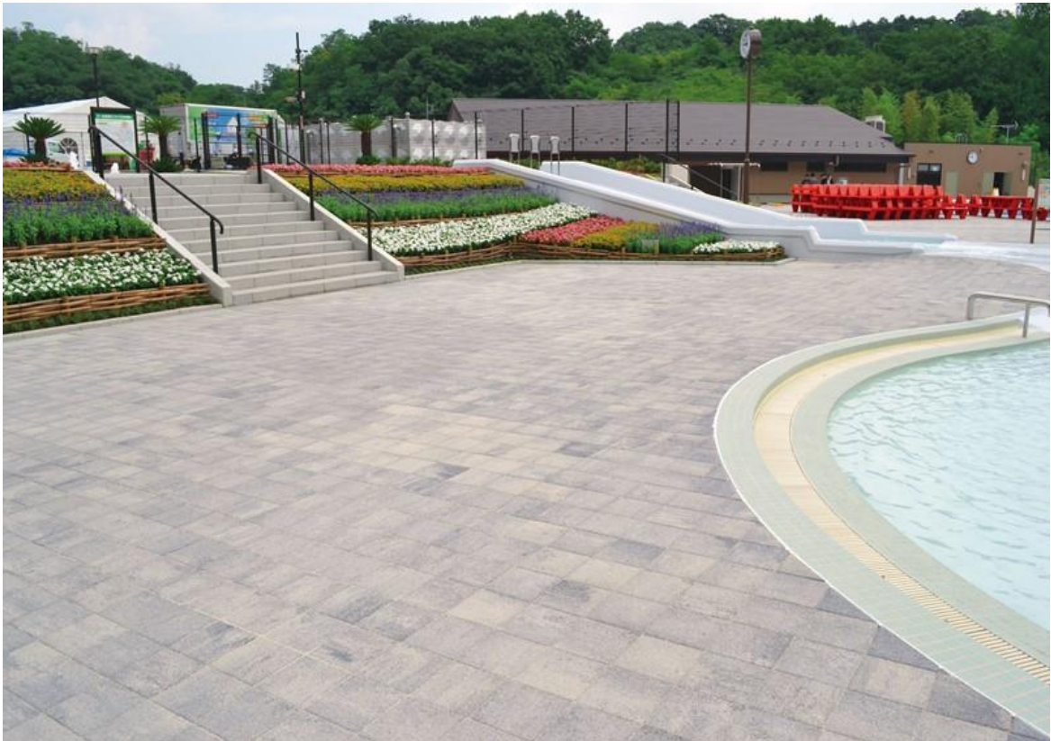
写真4 路面温度上昇抑制型 IL ブロックの施工例
