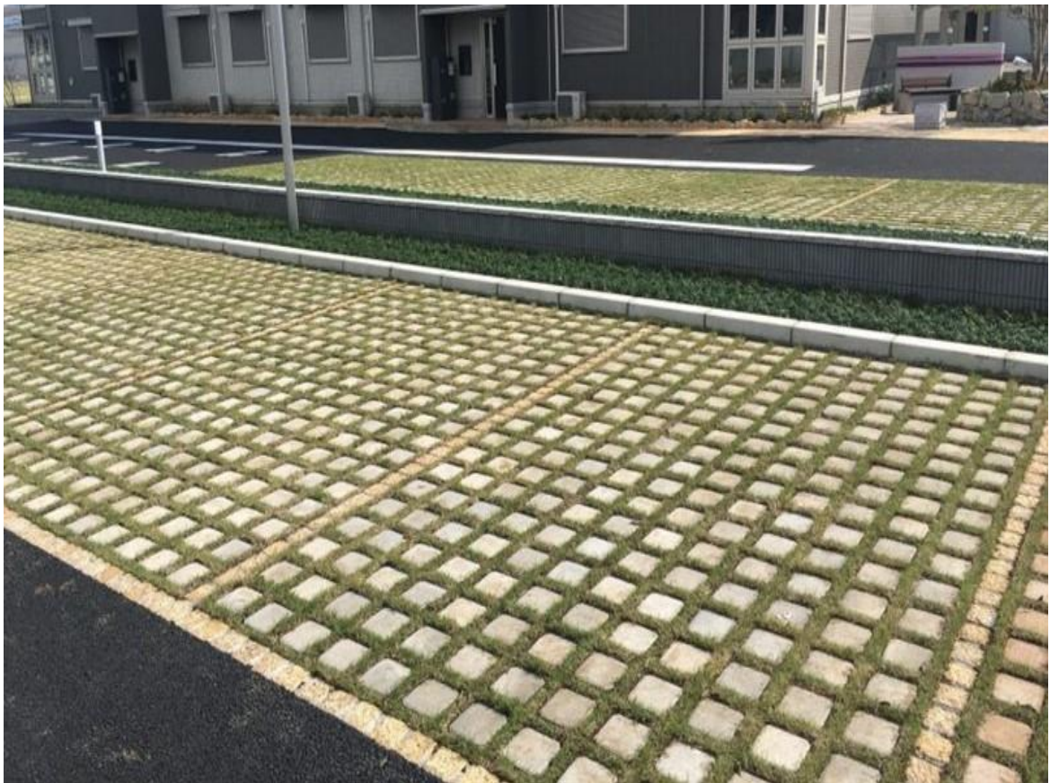
写真5 植生用(緑化)ブロックの施工例
