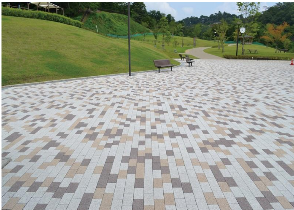
写真1 普通 IL ブロックの施工例
