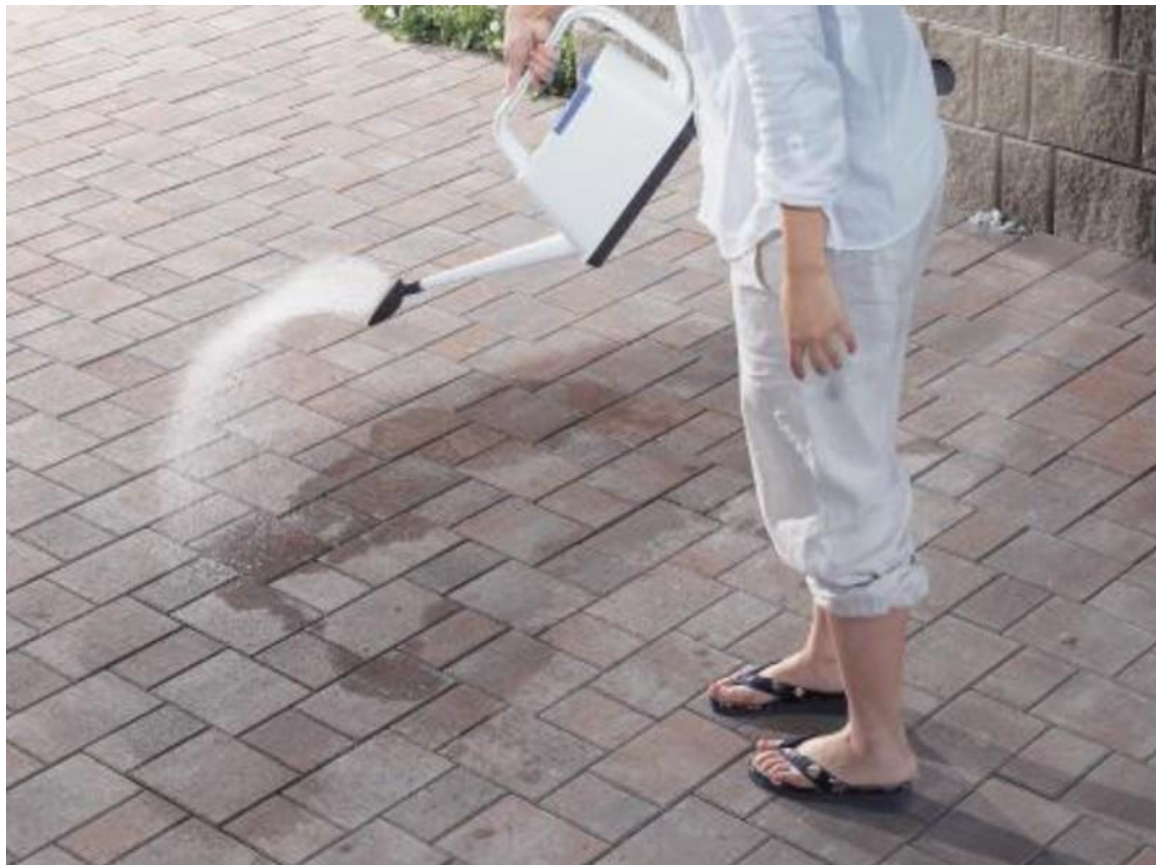
写真3 保水性 IL ブロックの施工例
