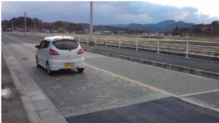
写真1 福岡県鞍手郡小竹町での車道統一型 IL ブロック舗装の実証試験
