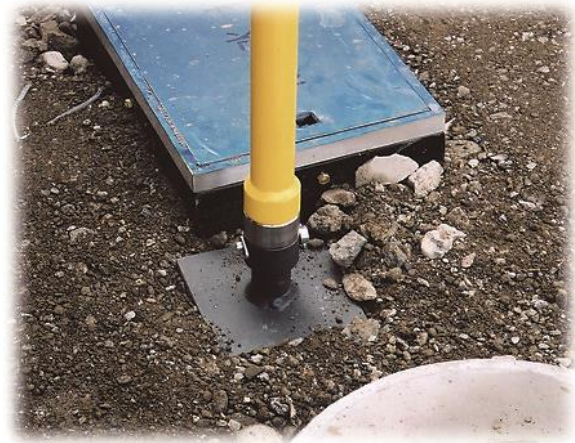
写真 6 手動インパクトツールによる 柵周りの締固め
