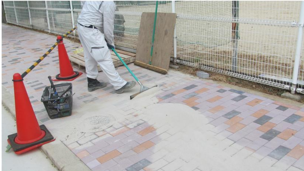
写真1 目地砂の再充填作業
