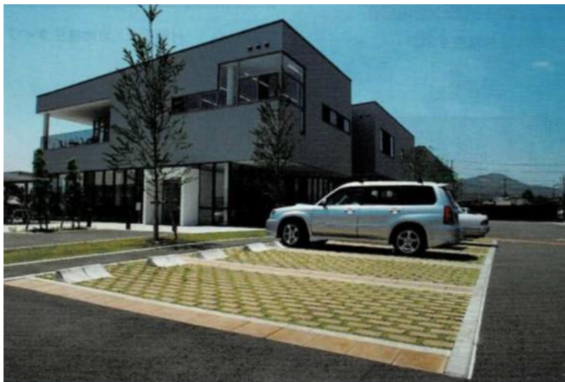
写真1 駐車場での緑化率向上を目的にした施工事例
